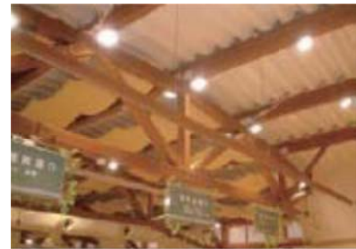
店舗内の LED 照明
