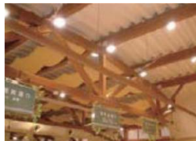
店舗内の LED 照明
