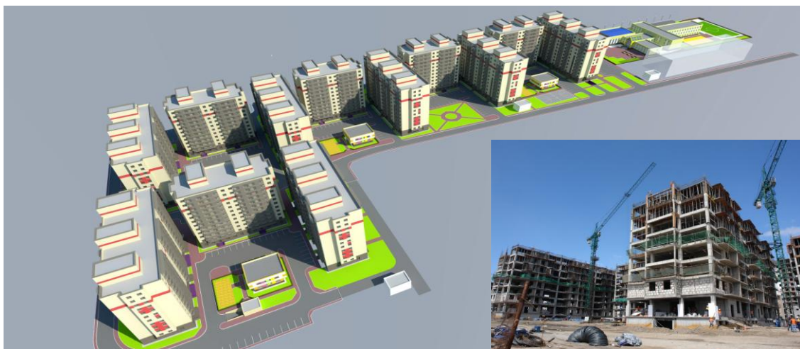
建設中のエリントウン
